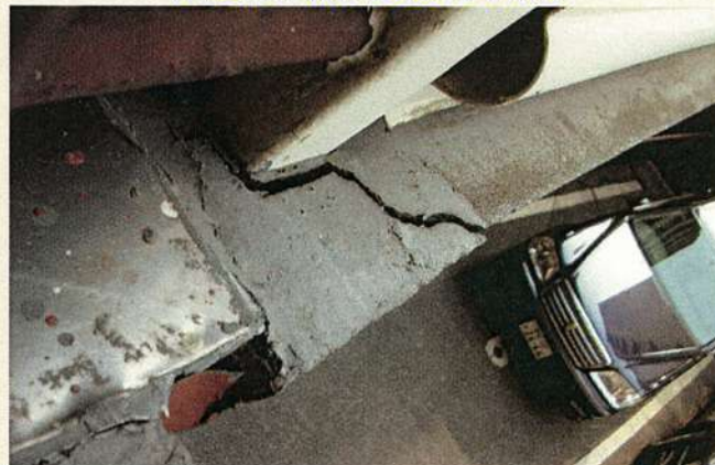
・手摺付根欠損(欠落)
