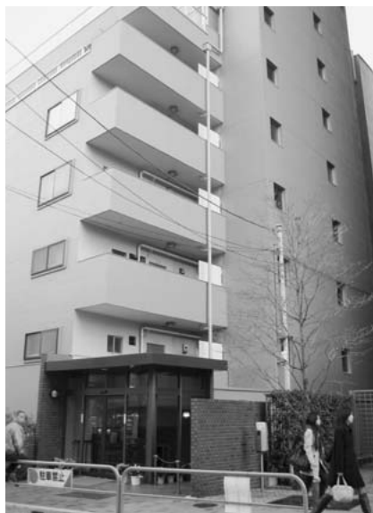
▲無事大規模改修を終えたコーポ麹町 (平成20年3月撮影)
