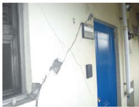
▲壁せん断破壊
