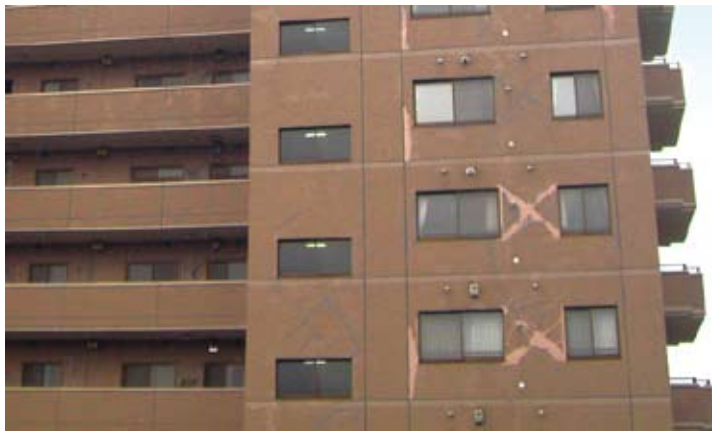
▲改修中のマンション
